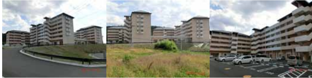
下和野災害公営住宅↑
