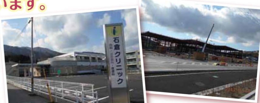
▲大手水産会社の新工場を建設中。
