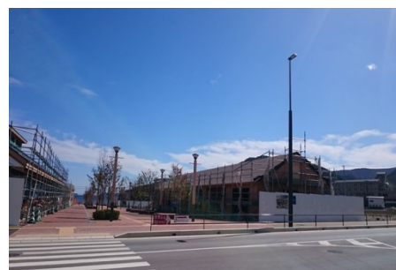
女川駅前商店街 建設工事の様子 （12月末オープン予定）
