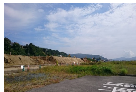
石巻市門脇地区 かさ上げ工事が進んでいます
