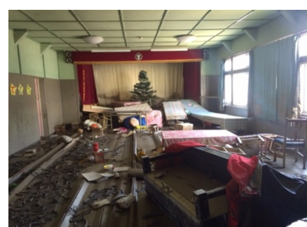
旧聖母幼稚園の室内 左：片付け前
