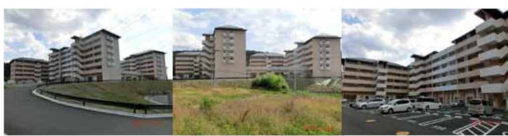
下和野災害公営住宅↑
