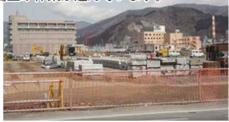
2016年3月12日に開業した新しい大船渡プラザホテル(左)。旧ホテル(右)は解体され、跡地の嵩上げ作業が進んでいます。
